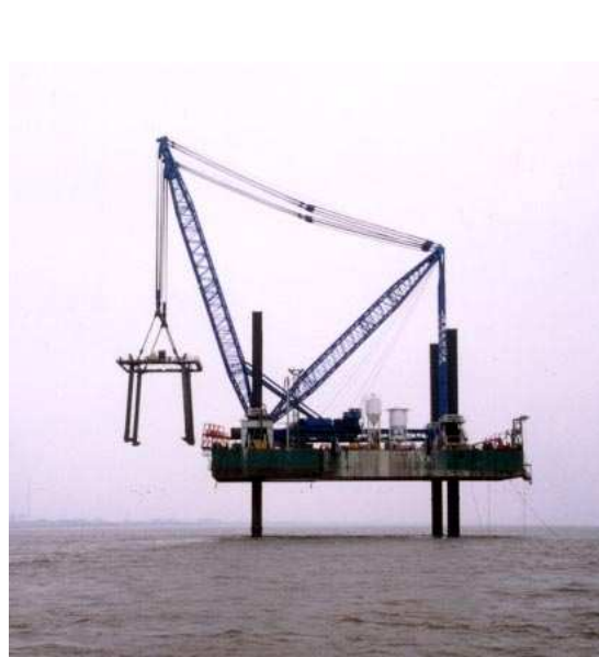
PONT SUR LE SEVERN EN ANGLETERRE POUR GTM-VINCI
