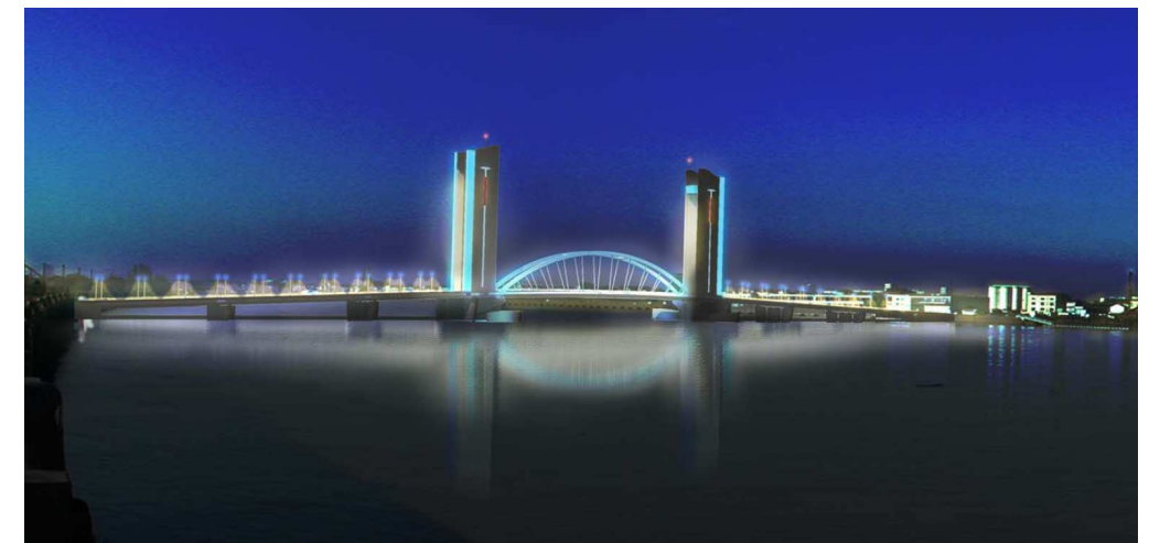
FRANCHISSEMENT DE LA GARONNE SUR LE PONT BACALAN-BASTIDE A BORDEAUX
